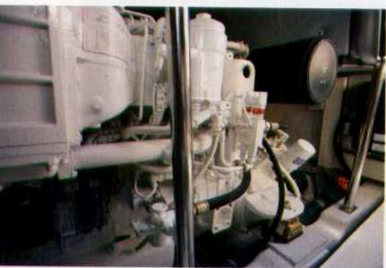
La sala motori ospita due entroboard Man Common Rail V8 da 900 cavalli.
